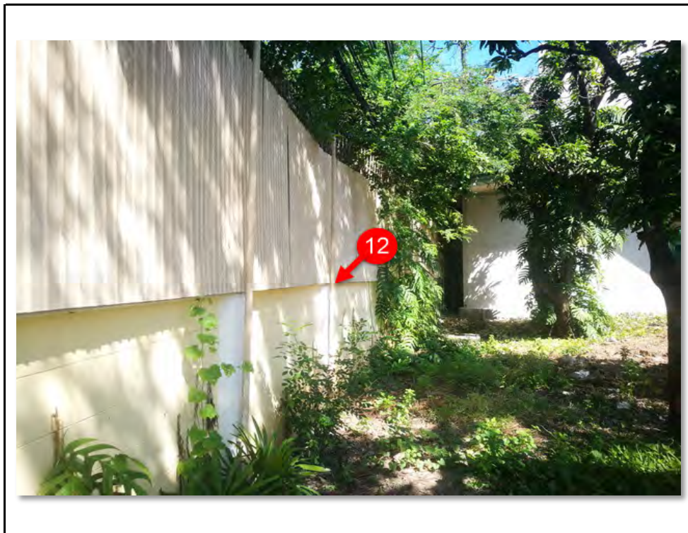
รูปที่ 17 ภาพถ่ายแสดงลักษณะขอบเขตพื้นที่โครงการ หมายเลข C-12
