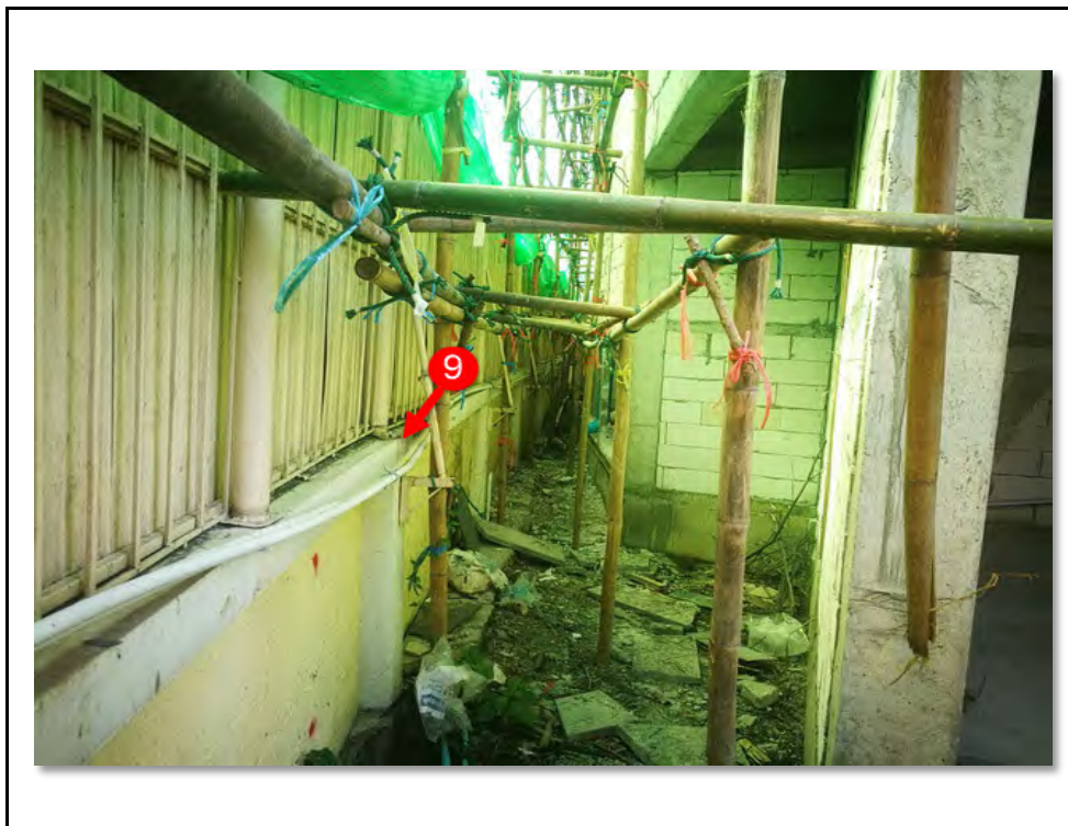
รูปที่ 14 ภาพถ่ายแสดงลักษณะขอบเขตพื้นที่โครงการ หมายเลข C-9
