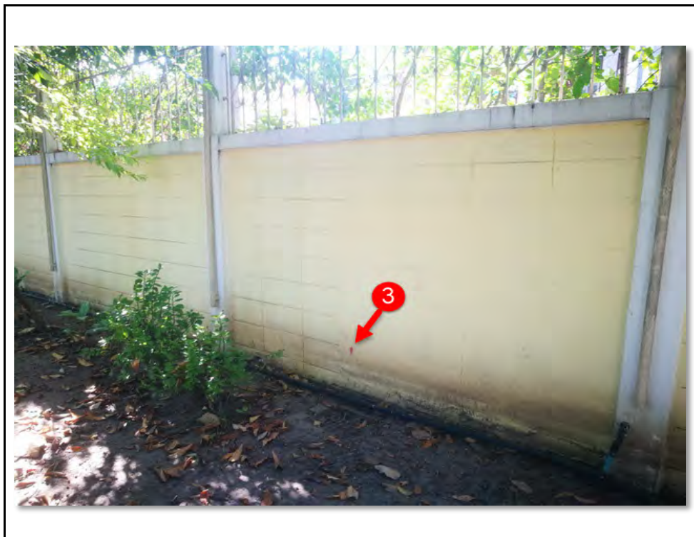
รูปที่ 8 ภาพถ่ายแสดงลักษณะขอบเขตพื้นที่โครงการ หมายเลข C-3
