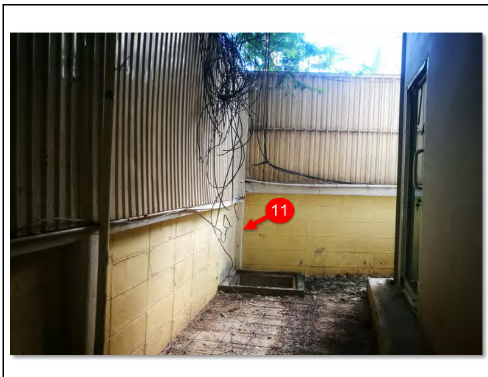
รูปที่ 16 ภาพถ่ายแสดงลักษณะขอบเขตพื้นที่โครงการ หมายเลข C-11
