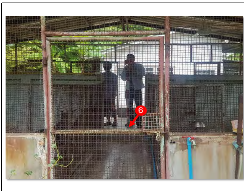
รูปที่ 11 ภาพถ่ายแสดงลักษณะขอบเขตพื้นที่โครงการ หมายเลข C-6
