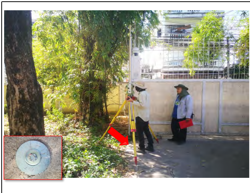
รูปที่ 5 ภาพถ่ายแสดงตำแหน่งหมุดหลักฐานแผนที่ถาวรทางราบ - ทางตั้ง เดิม หมายเลข NV-01
