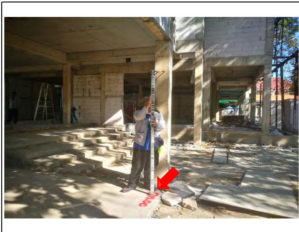
รูปที่ 3 ภาพถ่ายแสดงลักษณะและตำแหน่ง หมดระดับ BM-1
