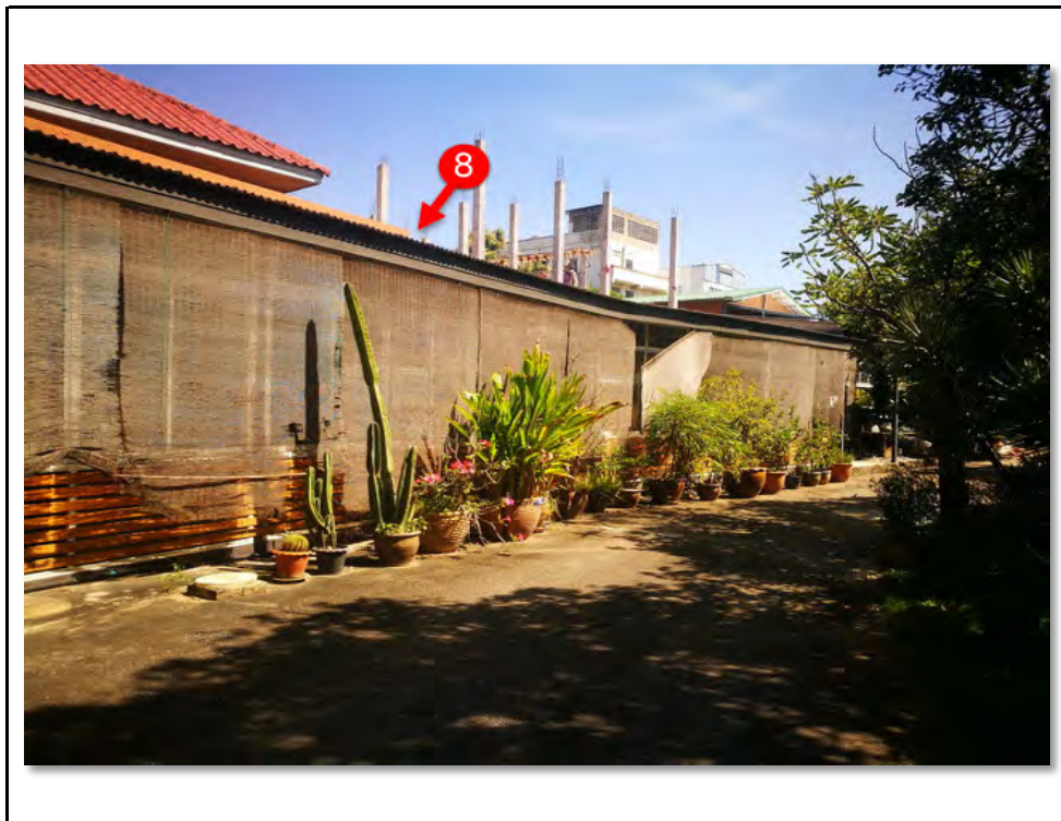
รูปที่ 13 ภาพถ่ายแสดงลักษณะขอบเขตพื้นที่โครงการ หมายเลข C-8
